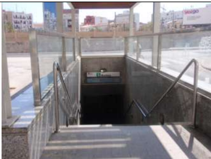
Entrada a la Estación situada en la calle Vila Barberá
