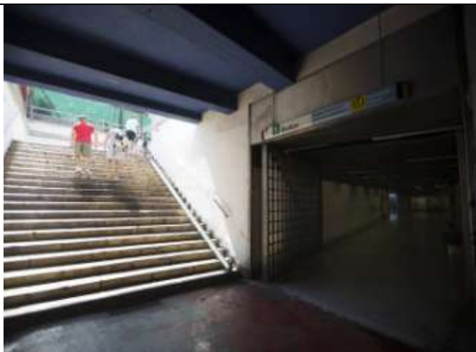
Entrada al vestíbulo de la Estación de Bailen y al paso peatonal.
